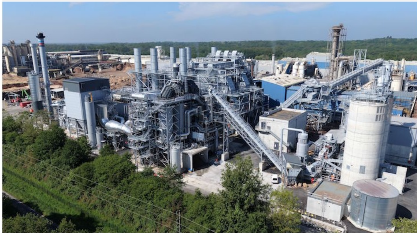
La centrale Green Energy à Sully-sur-Loire, photo Dalkia
